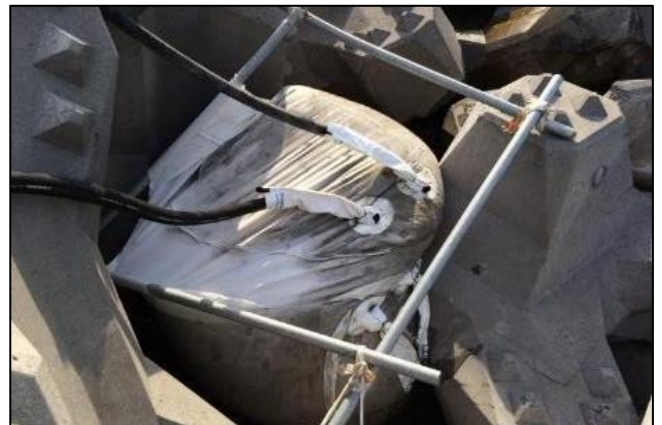
Exemple d'un big-bag injecté de béton au niveau de la digue du quai Laubeuf
